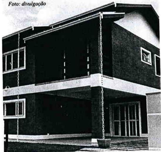
Os tijolos ecológicos, em vez de queimados em fôrma, são de solo-cimento prensado, molhado e curado, o que evita a queima de madeira
