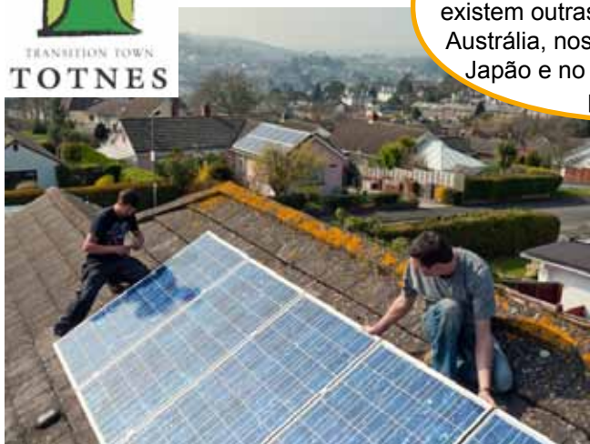
Instalação de painéis de energia solar em Totnes. Foto: http://www.transitiontowntotnes.org
